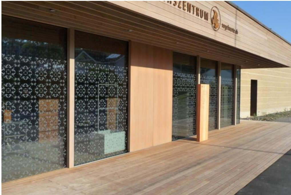
Abb. 6: Vogelfreundliche Gestaltung der Scheiben des Besucherzentrums der Schweizerischen Vogelwarte (aus der Broschüre „Vogelschlag an Glas“ des BUND, als pdf zu finden unter: https://www.bund.net/bund-tipps/detail-tipps/tip/vogelschlag-was-tun-dagegen/ )
